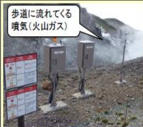
火山ガス濃度観測施設
